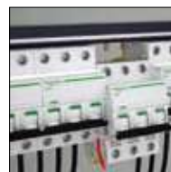
Работа при монтиран захранващ гребен
