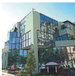
Управление на отоплението и вентилацията в сгради
